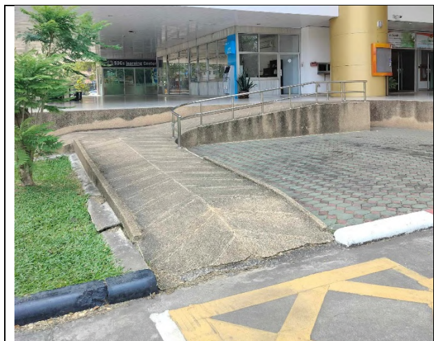
อาคารเรียนรวมและอำนวยการ
